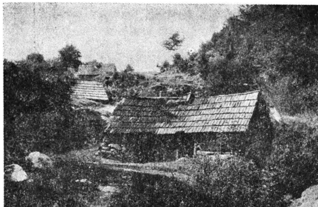
Fig. 19. Vedere parțială spre amonte a complexului Seleștiuț. Vue partielle de la partie supérieure du complexe Seleștiuț.
