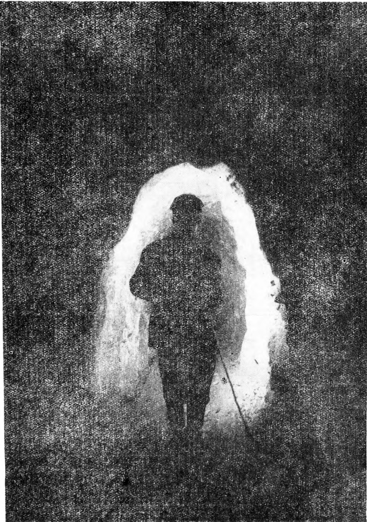
Profilul unei galerii de la Dognecea săpată cu dalta.
