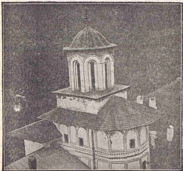
Paraclysisul mănăstirii Hurezi Înainte de restaurare.
