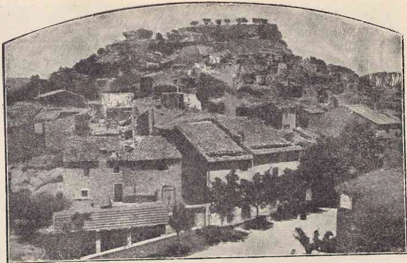
Vederea unei comune din sudul Franței prăpădită de cutremur.
