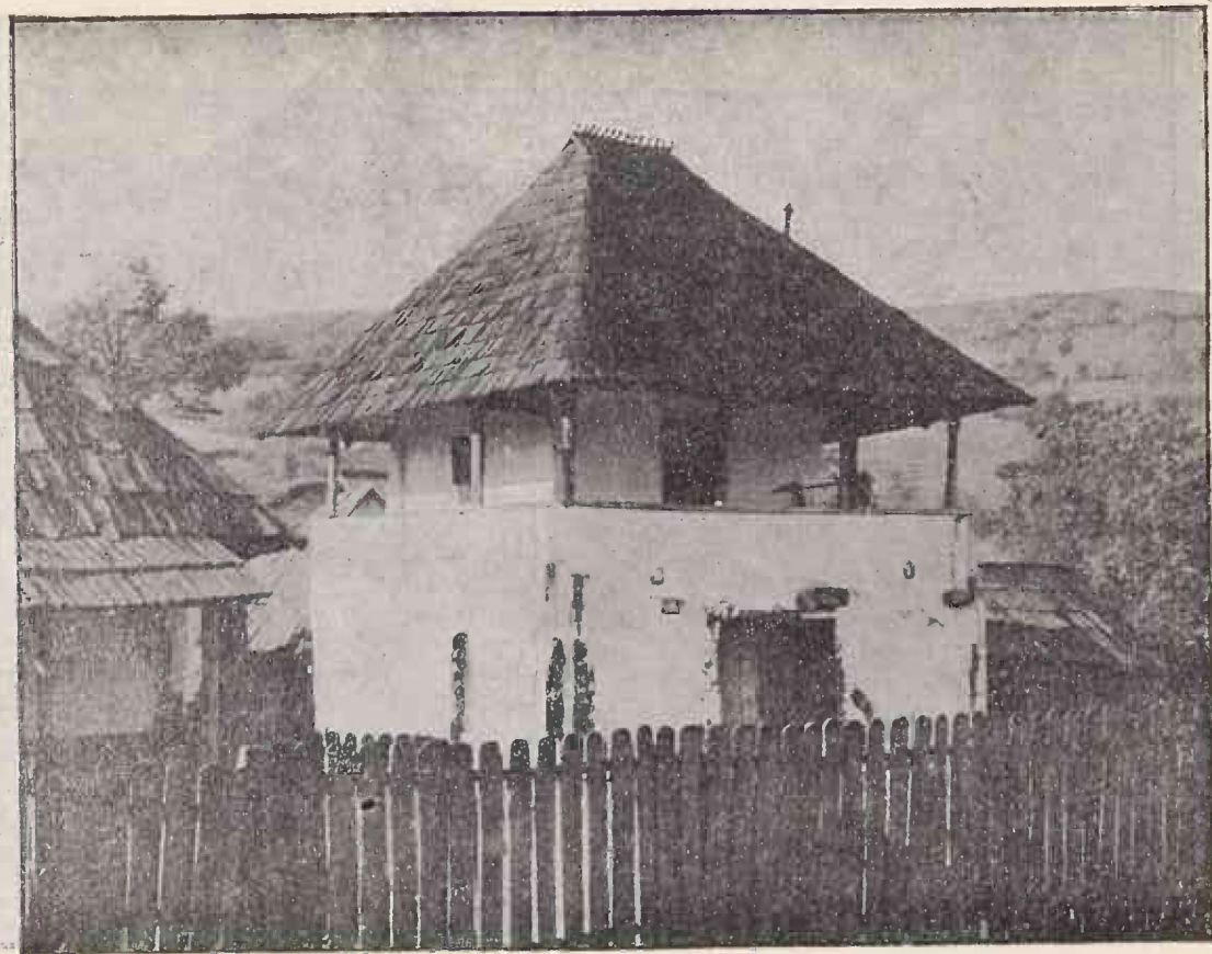
Fig. 5. Casă-Culă , pe drumul dela Calopăr, jud. Mehedinți.
