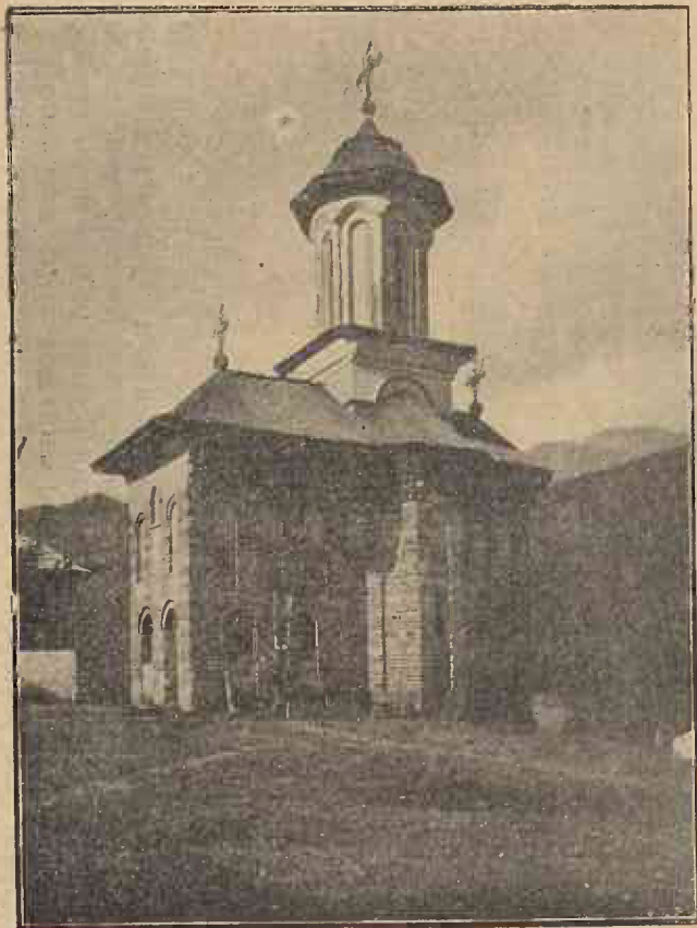
Bolnița mănăstirii Cozia. [înainte de reparație].
