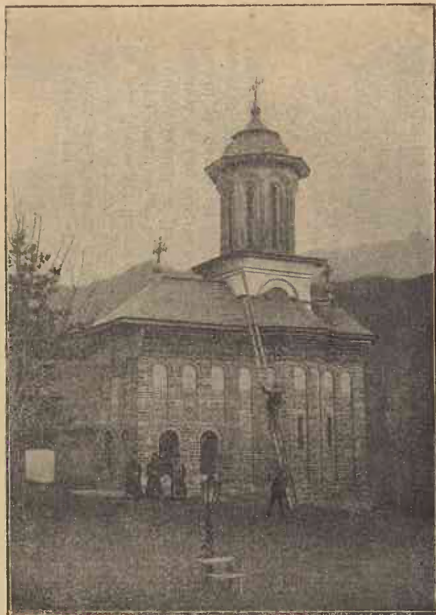
Bolnița mănăstirii Cozia. [după reparație].
