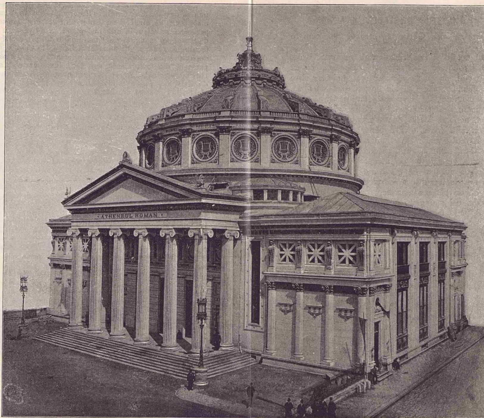
Palatul Ateneului Român, vedere exterioară.
