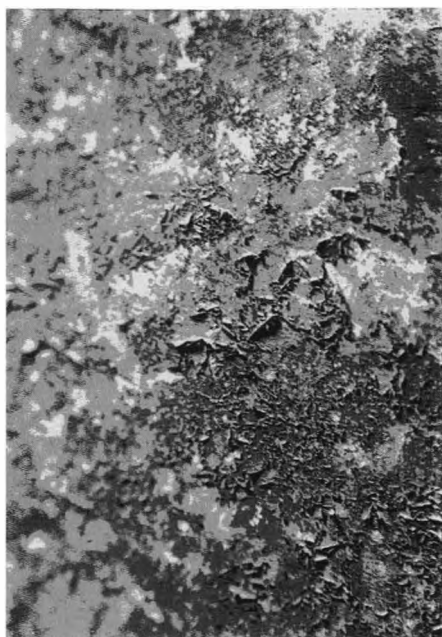
Fig. 1. Fenomene specifice de degradare a peliculei de culoare întâlnite la interior: exfoliere și pulverulență
