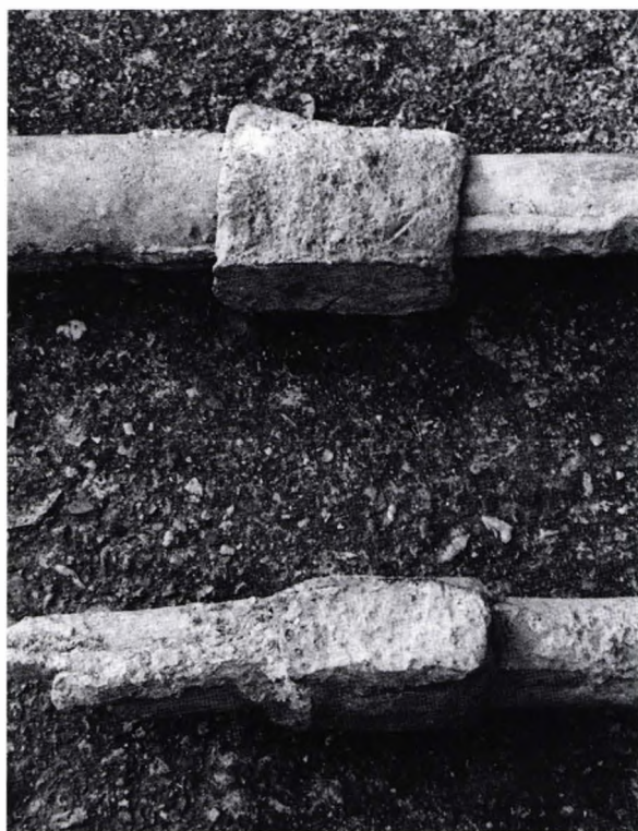
Fig. 3. - Les raccords des tuyaux.
