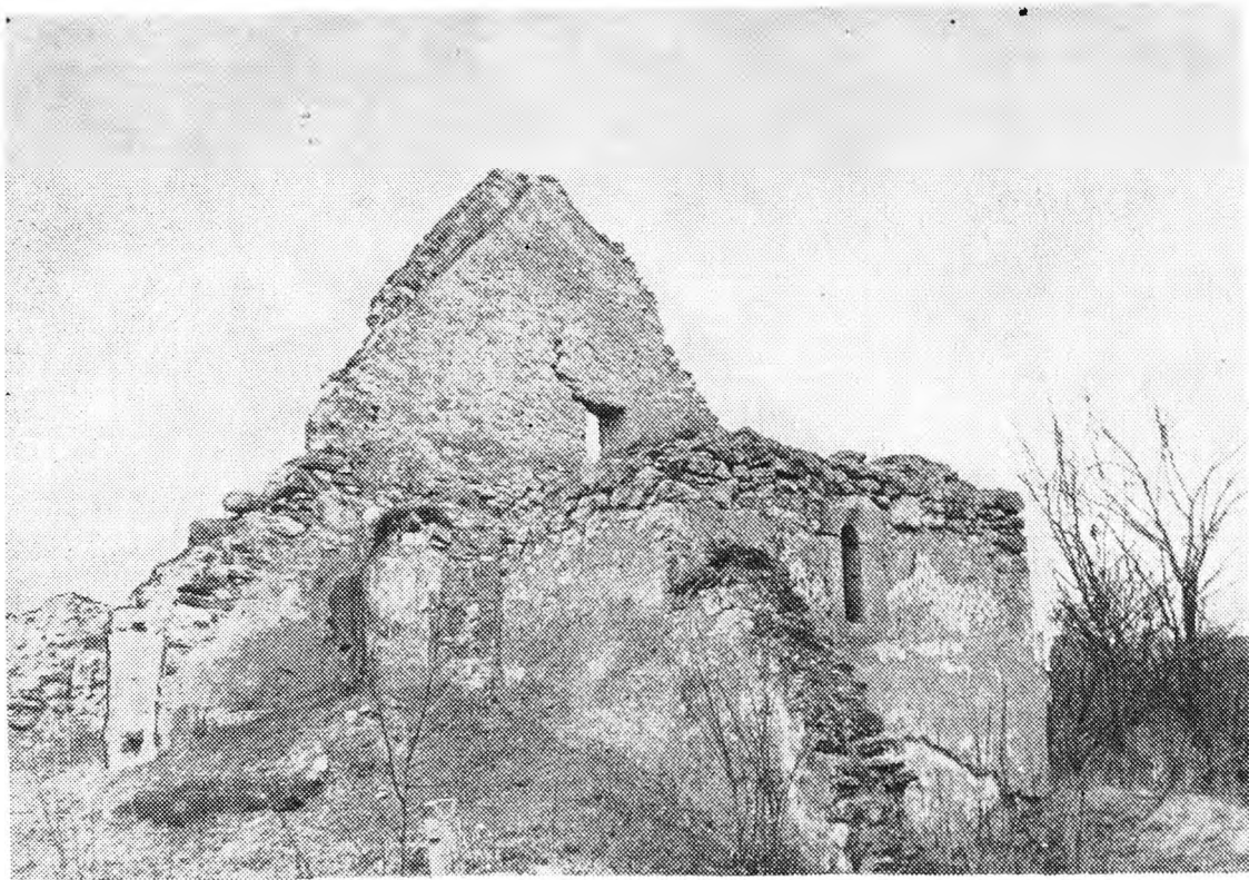
Fig. 3 — Girbova de Sus. Vederea ruinei bisericii dinspre sud-est.
