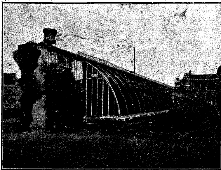
Fig. 312 - Seră cu un versant, construcție în beton armat și sticlă
