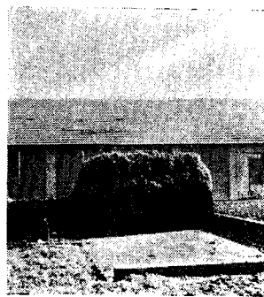
Fig. 1095 - Platformă betonată la gospodărie mică
