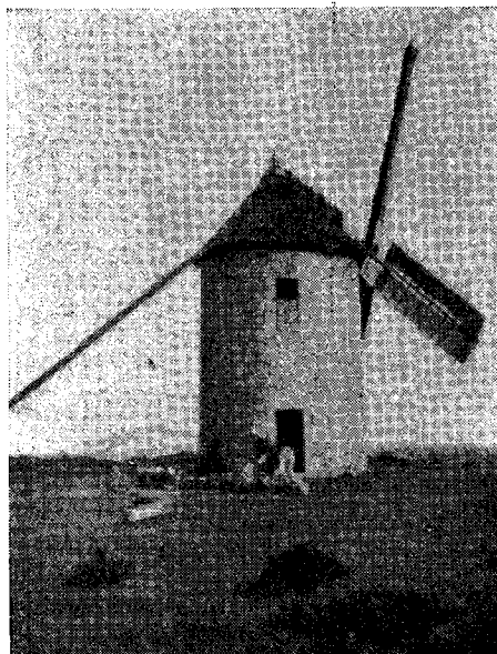
Fig. 93. — Moară de vânt cu aripi și acoperiș mobil.
