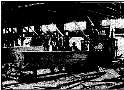
Fig. 837. — GATER TÂIND UN BUȘTEAN „PE PRISME”.
