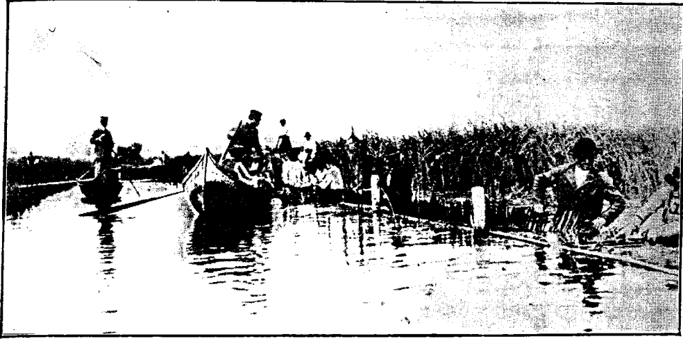
Fig. 309. — Închiderea bălților domeniului Brăila cu „Pieter“ așezat pe mal. Parii fiind gata bătuți și gardul de ostrețe plutind alături, se ridică în picioare, se leagă de pari și se bate cu maiurile în pământ. — Cliseu Gr. Antipa.
