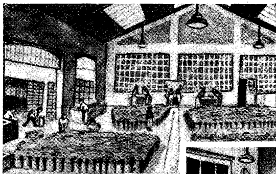
Fig. 653. — ELVEȚIA. — Hala uzinelor Nestlé, unde laptele proaspăt este răcit la temperatura de 10-12', pentru evitarea proliferării florei microbiene.
