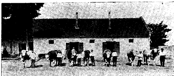
Fig. 836. — Grajd comunal — CAMERA de TIMIȘ-TORONTAL.
