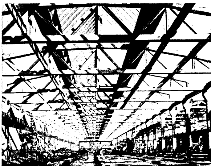
Șarpantă cu ferme din panouri prefabricate asamblate prin precomprimare la Combinatul de industrializare a lemnului Blaj
