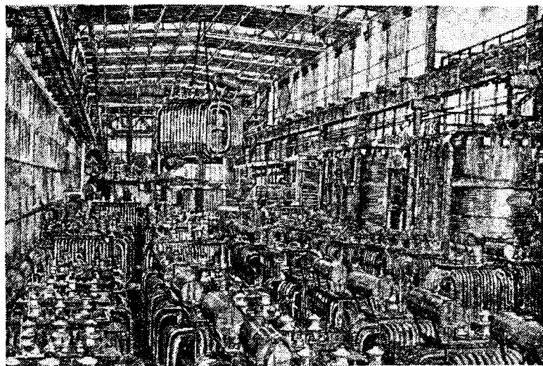
Craiova. Hala de montare a transformatoarelor de la Uzinele „Electroputere”
