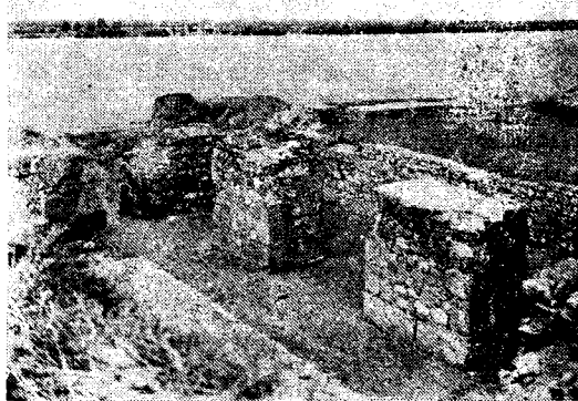
Interiorul turnului central de pe latura de NV
