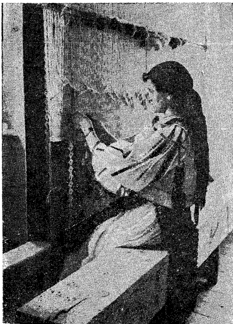
Fig. 444. Război de țesut vertical, Cisnădie, Sibiu.
