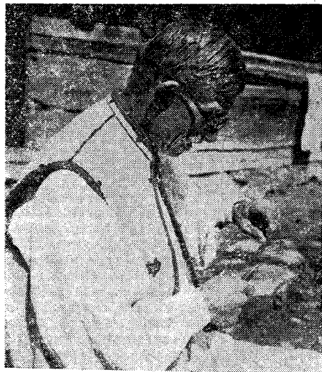
Fig. 411. Meșter turnînd ținte de balți, Pădureni, Hunedoara, sec. 20.
