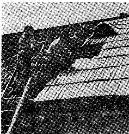
Fig. 224. Bătutul draniței pe acoperiș, Dragomirești, Maramureș, 1979.
