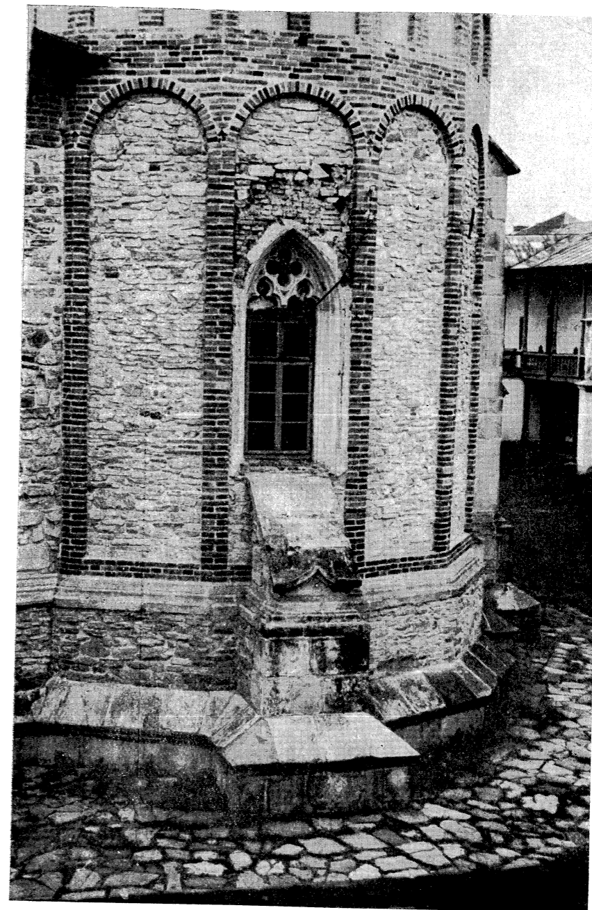
Fig. 28. Fațada de est a bisericii. Absida altarului
