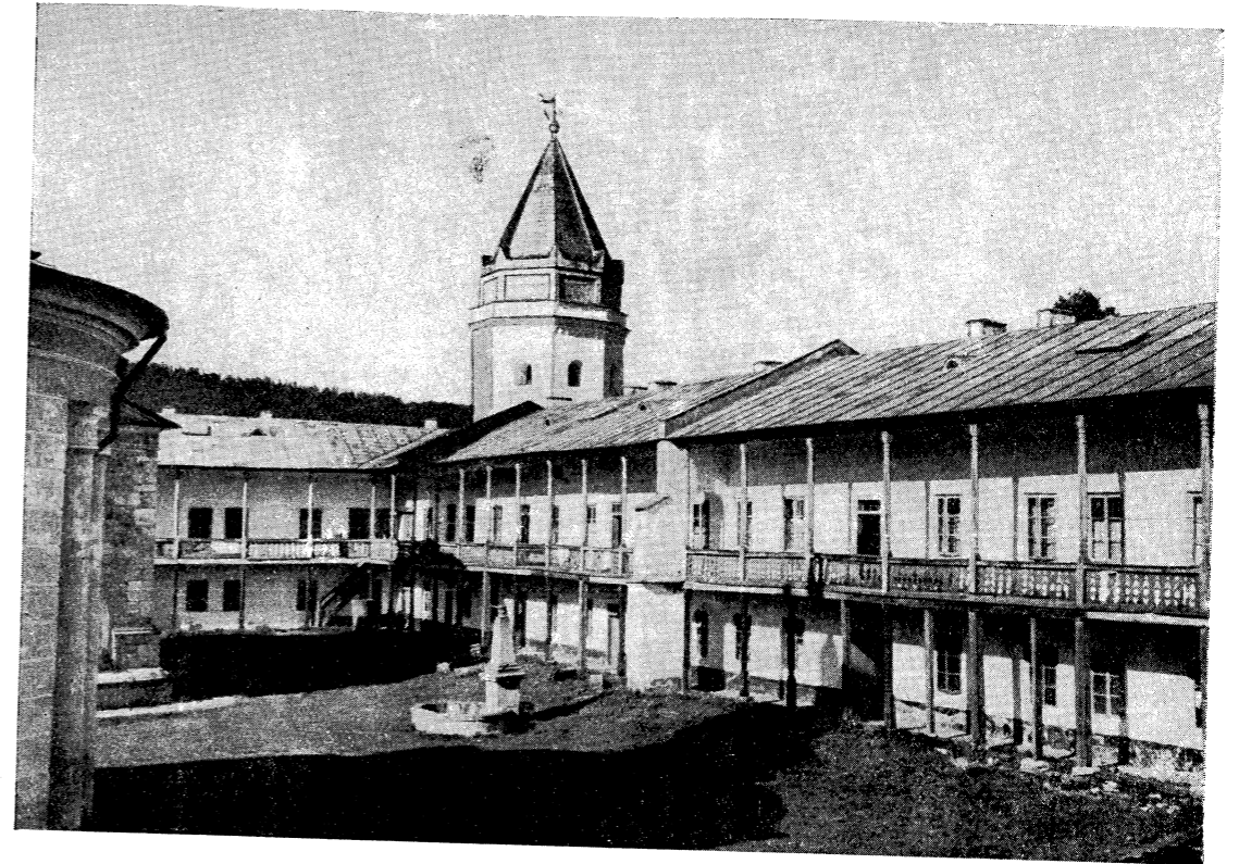
Fig. 83. Curtea interioară. Latura est, înainte de restaurare
