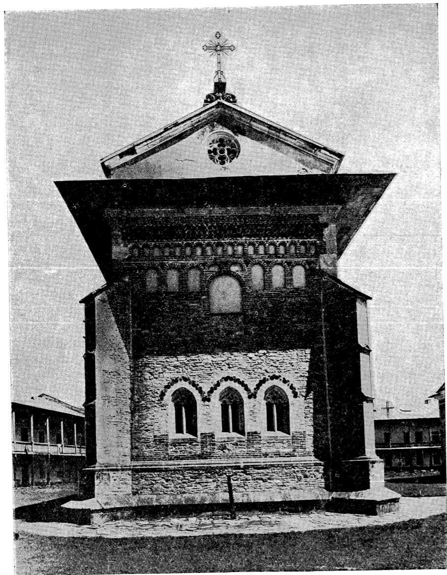
Fig. 13. Biserica mare. Fațada vest
