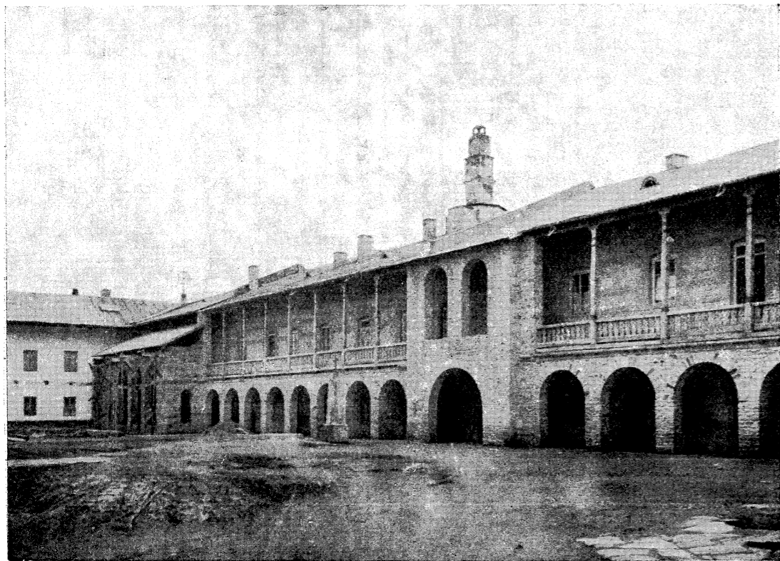
Fig. 88. Curtea interioară. Latura sud, în curs de restaurare
