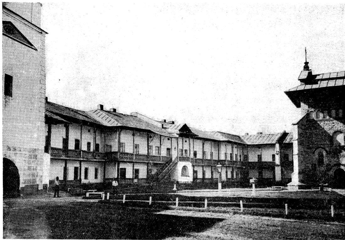
Fig. 80. Curtea interioară. Latura vest, înainte de restaurare
