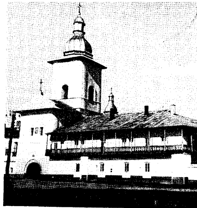
Fig. 54. Turnul-clopotniță. Fațada exte
