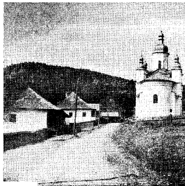
Fig. 73. Schitul Vovidenia. Vedere din sud
