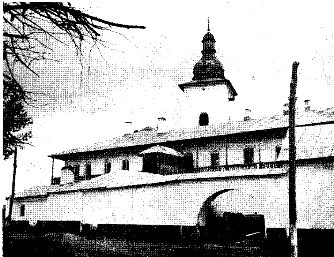
Fig. 62. Vederea fațadei sud a incintei
