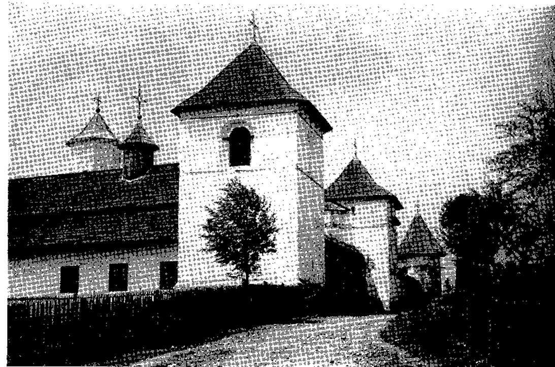
Fig. 74. Turnul-clopotniță de la sud-est, înainte de restaurare
