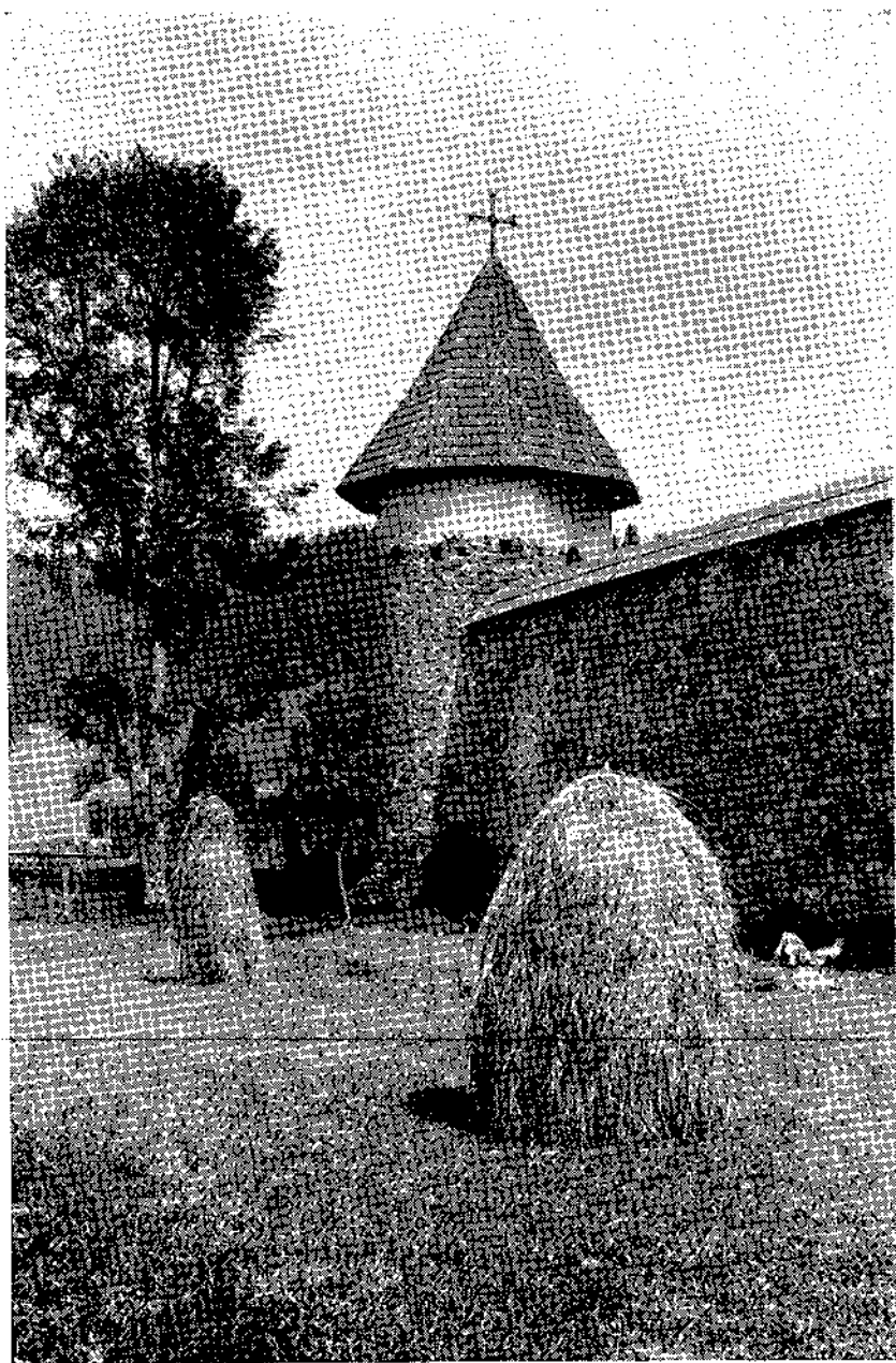
Fig. 71. Turnul de nord-est, văzut din exterior
