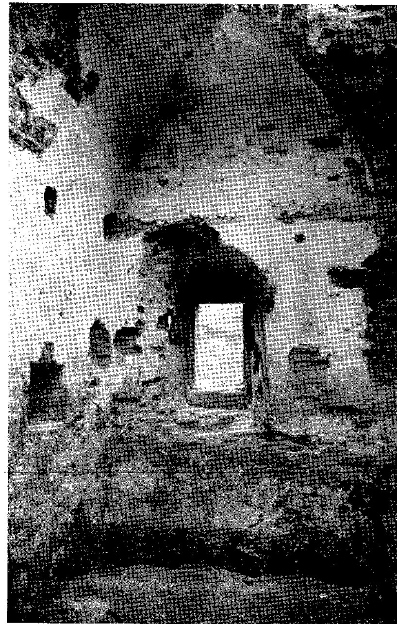
Fig. 84. Clisiarnița. Interiorul camerei 2 de la parter, după îndepărtarea pământului
