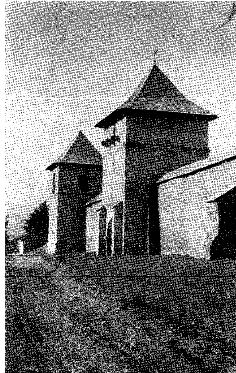
Fig. 64. Zidul de împrejmuire est, după restaurare
