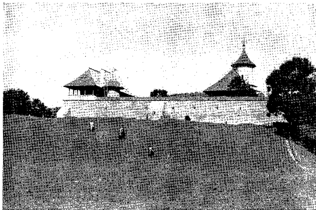
Fig. 52. Clisiarnița văzută dinspre vest, după restaurare
