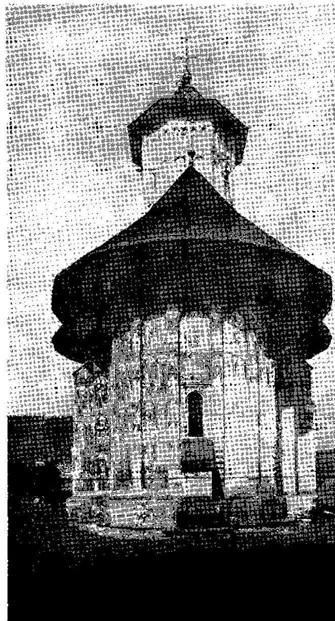
Fig. 12. Biserica văzută dinspre est. înainte de restaurare
