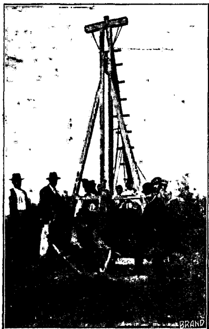
Fig. 106. Baterea reperelor în pământ.
