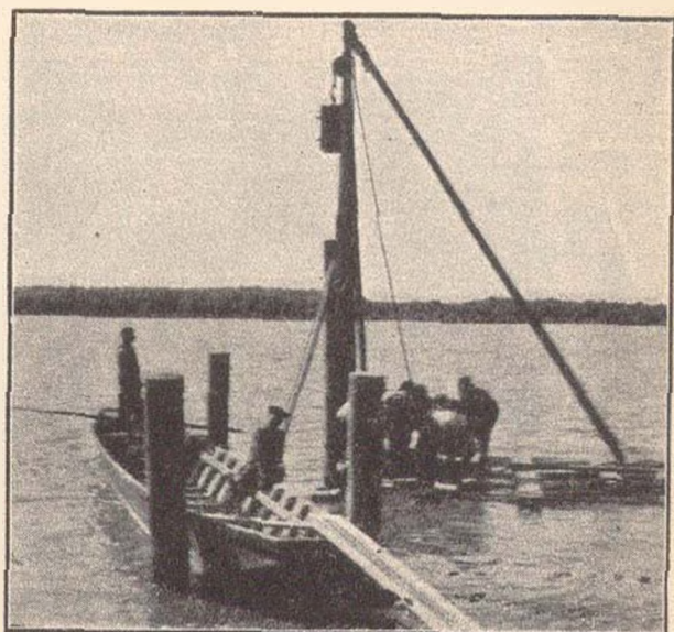
Fig. 314. O sonetă pentru bătut parii la gardurile mari (dom Brăilei).
