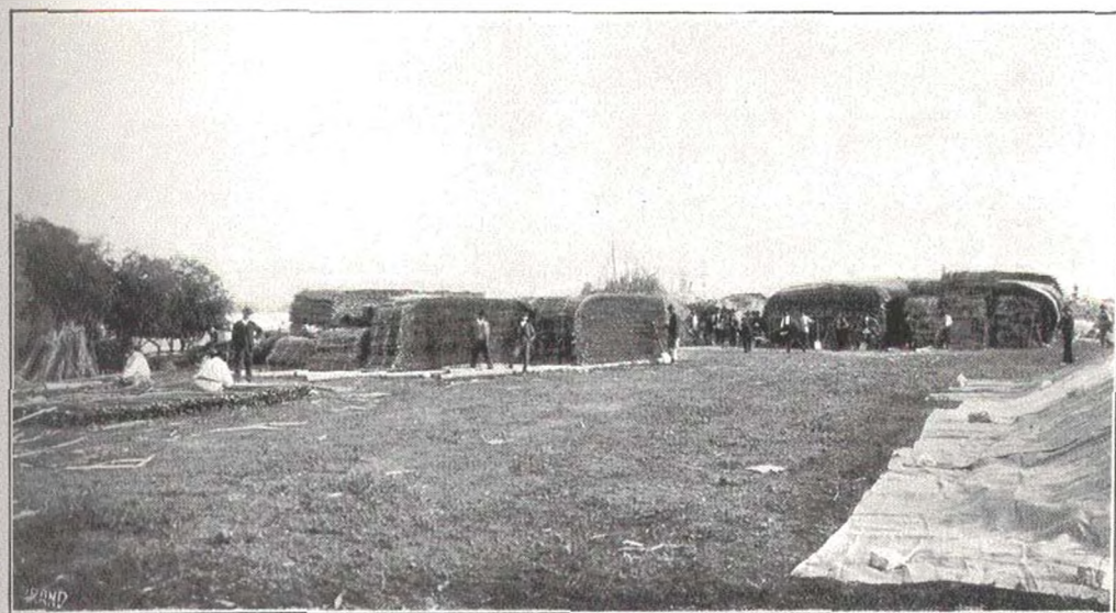
PREPARAREA MATERIALULUI PENTRU INCHISUL BĂLȚILOR DIN DOM. BRĂILEI. Sus: Impletirea ostrețelor de alun. — Jos: Un depozit de material lemnos gata împletit.
