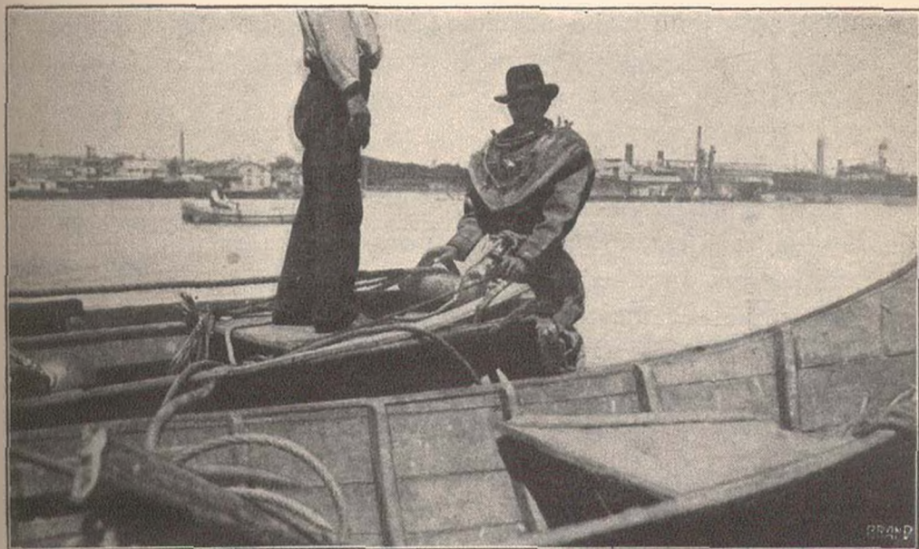
Fig. 361. Barca cu scafandrierul care scoate paii ruși (Miriștea) din fundul Filipoiului.
