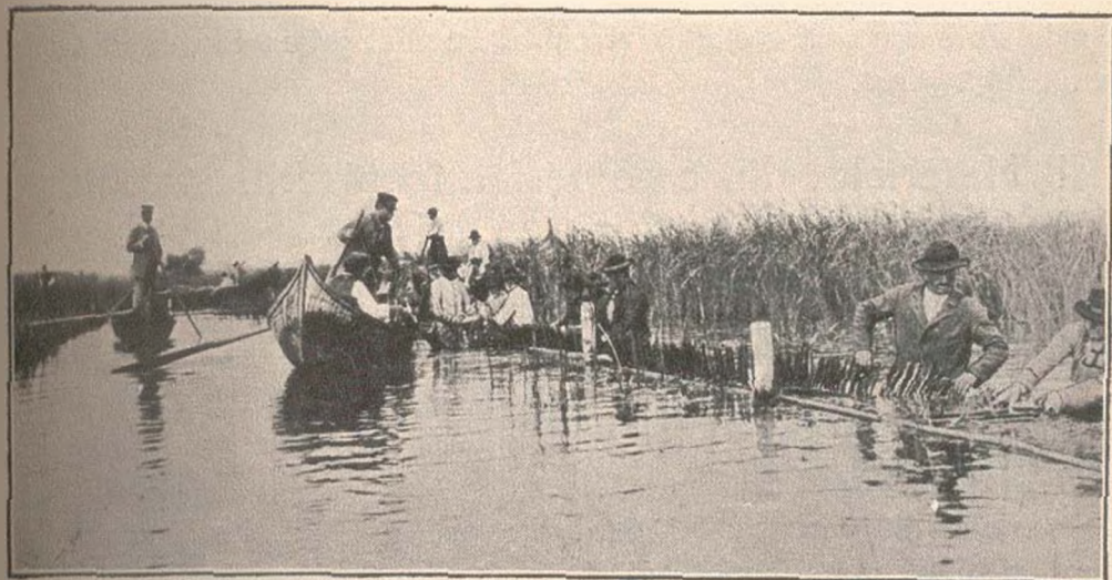
Fig. 310. Inchiderea bălților domeniului Brăila cu «Pleter» așezat pe mal. Parii fiind gata bătuți și gardul de ostrețe plutind alături, se ridică în picioare, se leagă de pari și se bate cu maiurile în pământ.
