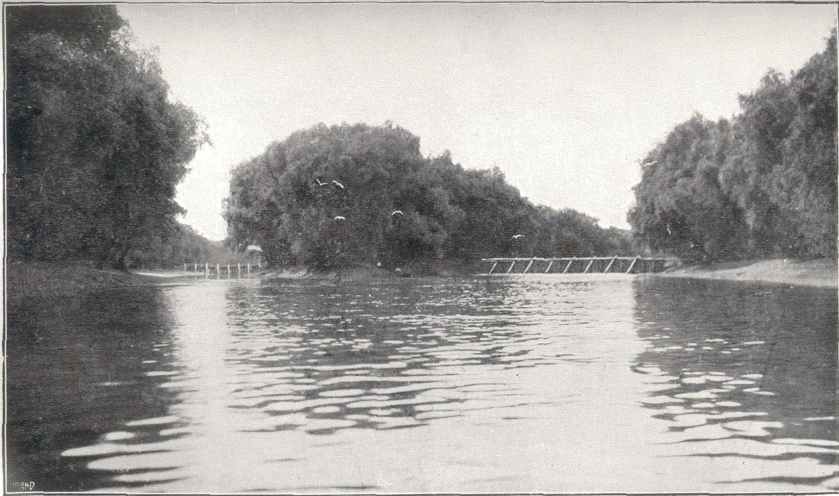
VEDERE ASUPRA GARDURILOR STERPE DELA SCURTU (STÂNGA) ȘI DELA FILIPOIU (DREAPTA).
