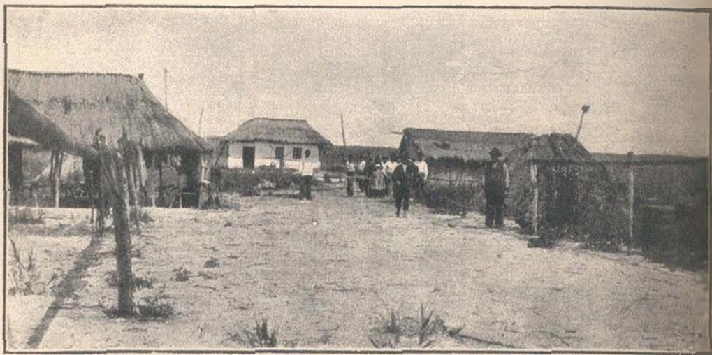
Fig. 160 bis. Vederea generală a unui Zăvod de Carmace dela coasta mării, așezat pe limba de nisip care separă Zatonul de mare.
