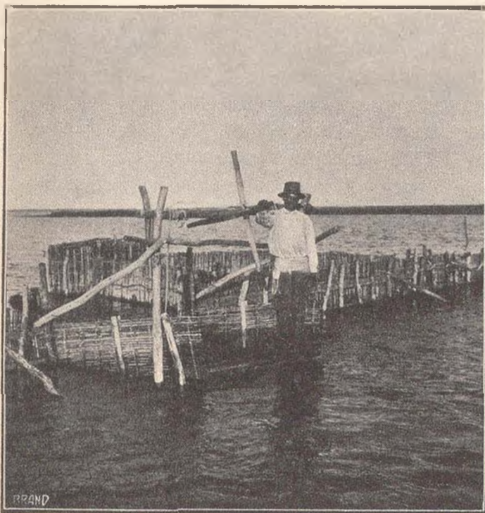
Fig. 349. O Călătoare și un Coteț dela gardul cel mare dela Caranasuf. Pescarul stă pe marginea călătoarei.
