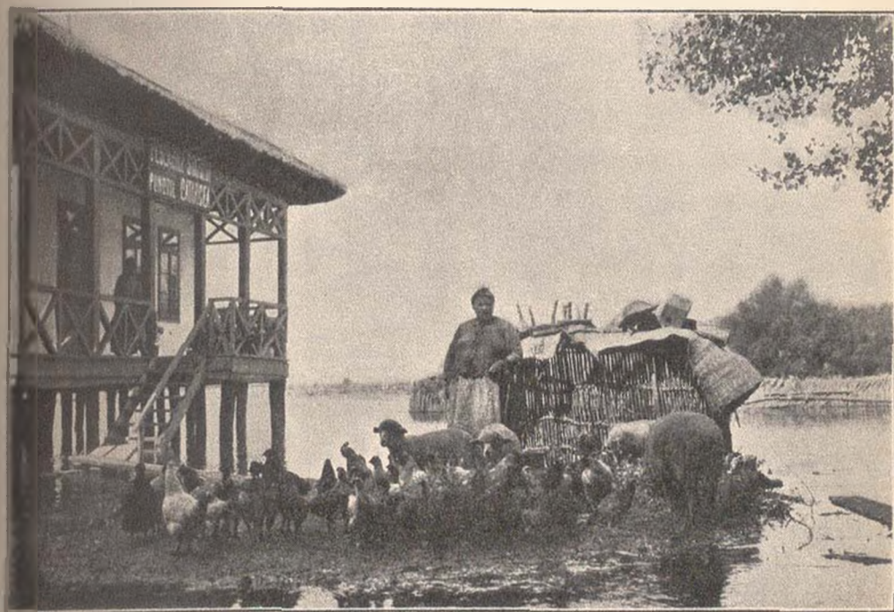
Fig. 89. Din efectele inundației din 1913 în Balta Brăilei.
