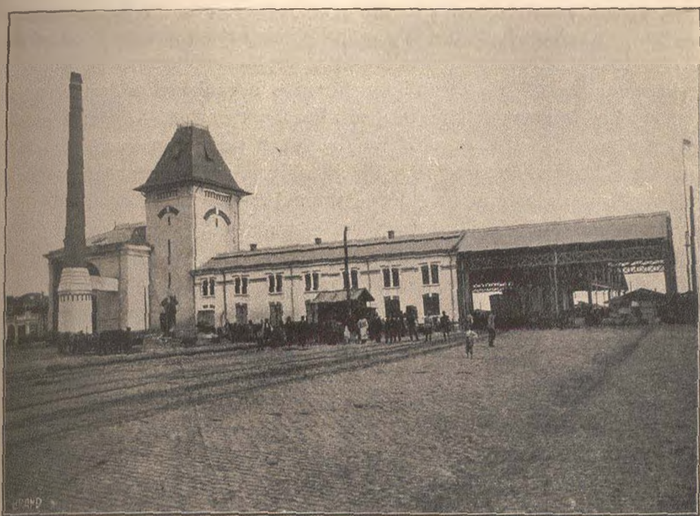
Fig. 383. Aspectul exterior al halei de pește cu frigorifere din Galați.
