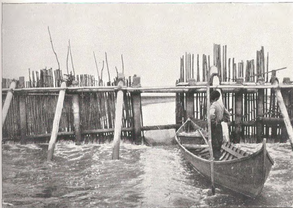
Sus: Gardul în formă de leasă fără coș, dela Gârla Corotisca din domeniu Brăilei. Jos: Gardul sterp cu sac, dela Privalul Boazul dela Balta Turtucaiei.
